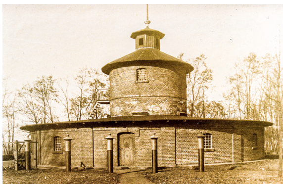
Technologiczny budynek odżelaziacza i stacji filtrów zlokalizowany na terenie Stacji Uzdatniania Wody w Zaborowie (początek XX w.). Podczas prac modernizacyjnych w latach 70. XX w. budynek został wyburzony.
