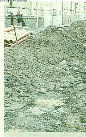
Remont ul. Chrobrego
