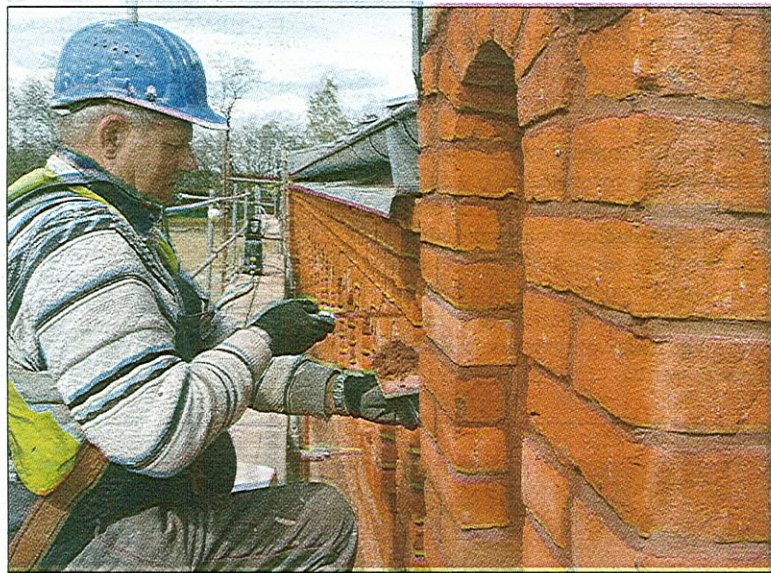
▲ Pan Marian z dużą starannością wypełnia fugi pomiędzy bardzo starymi już ceglami.
