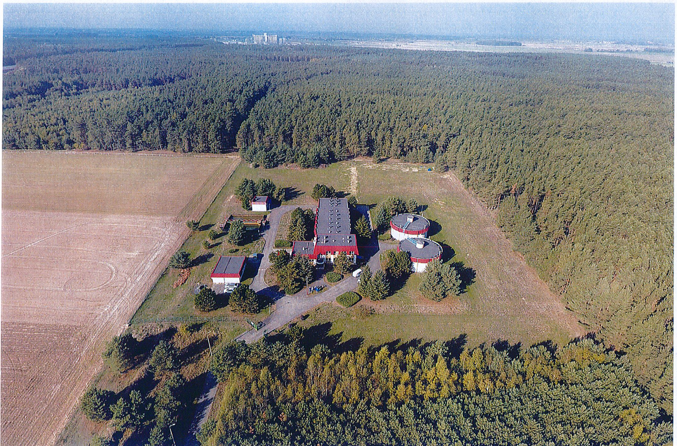
Ujęcie z drona – Stacja Uzdatniania Wody w Strzyżewicach.
