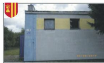
Stacja Uzdatniania Wody w m. Goniembice jednostka ewidencyjna 301302_2 Lipno obręb 0001 Goniembice, działka 193/12
