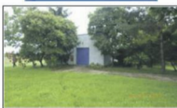
Stacja Uzdatniania Wody w m. Górka Duchowna jednostka ewidencyjna 301302_2 Lipno obręb 0002 Górka Duchowna, działka 195/2
