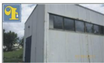
Stacja Uzdatniania Wody w m. Lipno jednostka ewidencyjna 301302_2 Lipno obręb 0006 Lipno, działka 112/9
