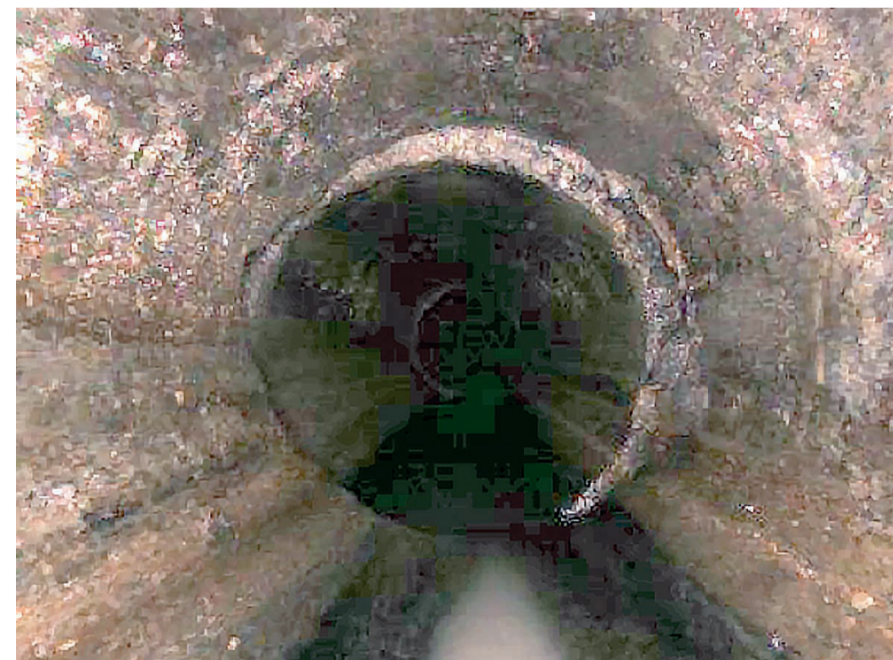
▲Zdjęcia z przeprowadzonej specjalistyczną kamerą inspekcji kanalizacji ogólnospławnej, ukazujące przesunięcie rury na łączeniu kanału (powodujące infiltrację wody gruntowej do kanału) i korozję betonu (duży ubytek w górnej części kanału), wykonane na potrzeby opisanej inwestycji w ul. Fabrycznej. Zdjęcia z zasobów archiwalnych MPWiK Sp. z o.o. w Lesznie.
