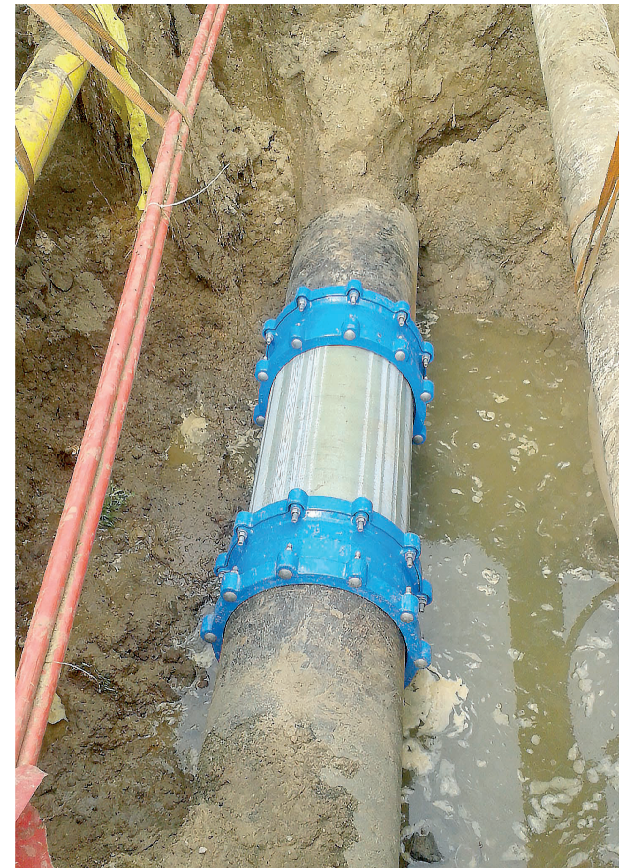
▲Zdjęcie naprawionego odcinka magistrali wodociągowej DN 500 mm w ul. Fabrycznej po awarii w 2015 roku. Zdjęcie z zasobów archiwalnych MPWiK Sp. z o.o. w Lesznie
