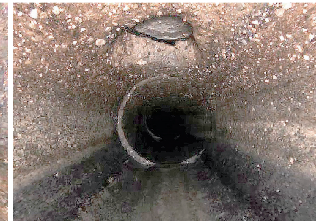
▲Zdjęcia z przeprowadzonej specjalistyczną kamerą inspekcji kanalizacji ogólnospławnej, ukazujące przesunięcie rury na łączeniu kanału (powodujące infiltrację wody gruntowej do kanału) i korozję betonu (duży ubytek w górnej części kanału), wykonane na potrzeby opisanej inwestycji w ul. Fabrycznej. Zdjęcia z zasobów archiwalnych MPWiK Sp. z o.o. w Lesznie.
