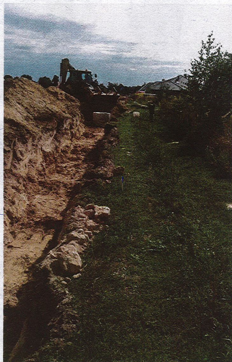
Budowa sieci kanalizacyjnej.
