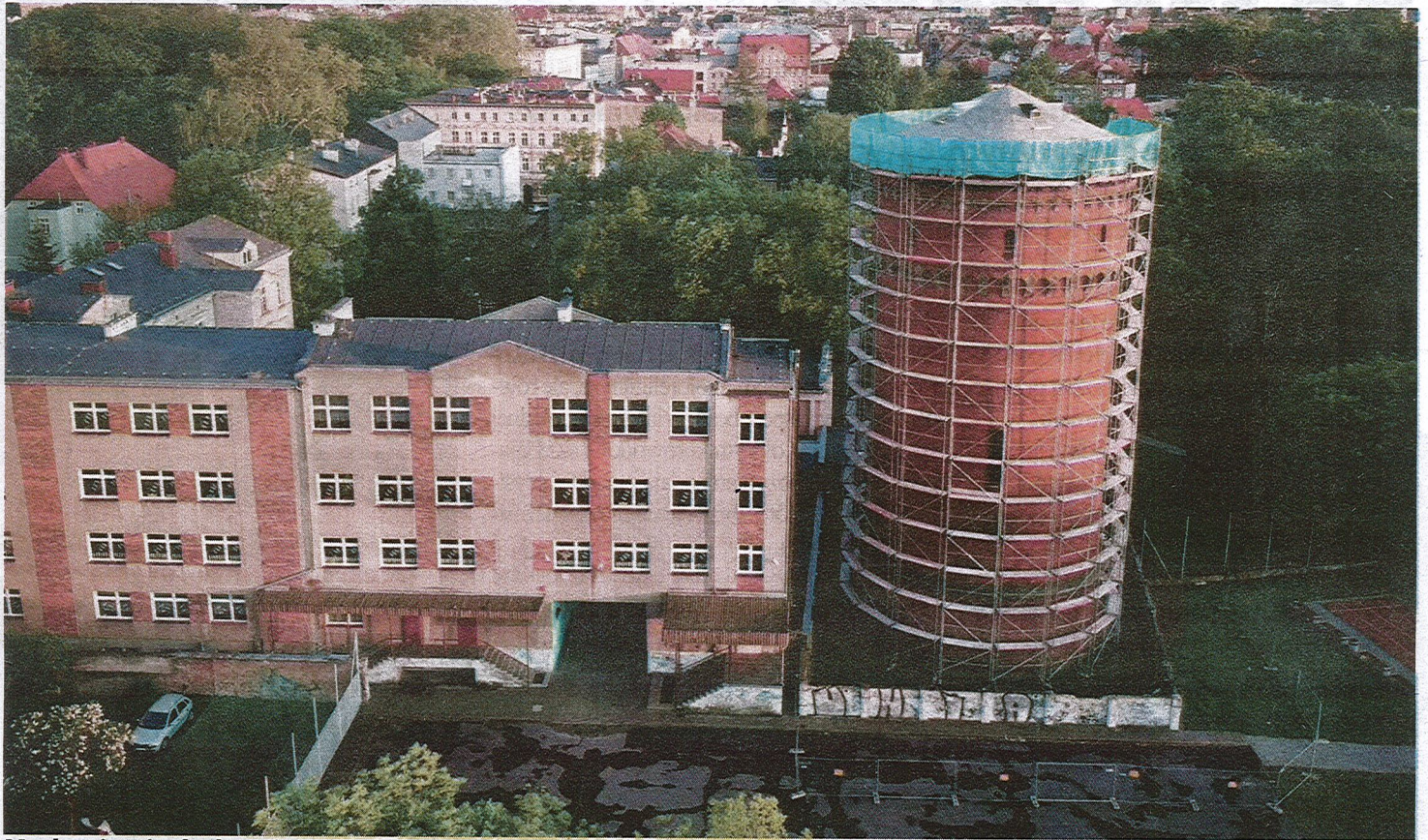
Modernizacja dachu wieży ciśnieniowej przy ulicy Poniatowskiego w Lesznie.
