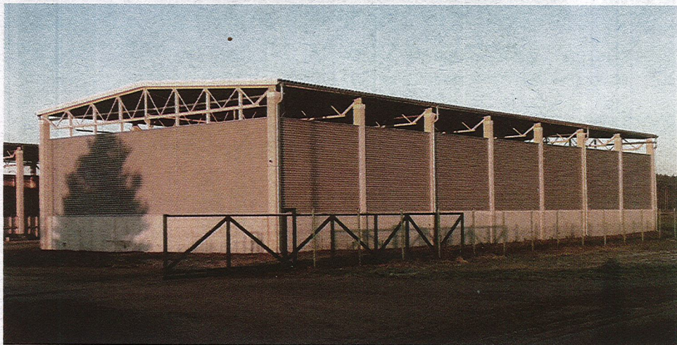
Oczyszczalnia ścieków w Henrykowie - montaż osłon przeciwwiatrowych.
