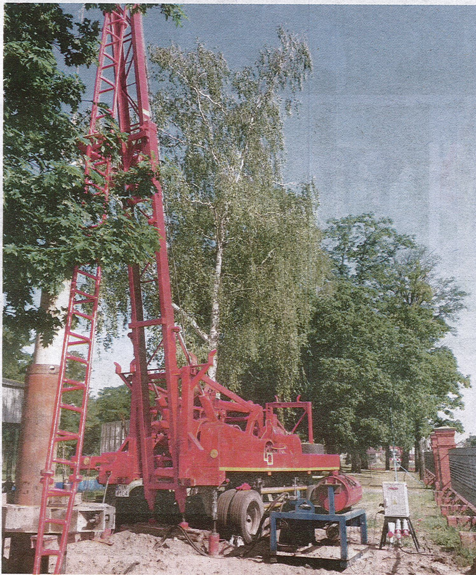
SUW Zaborowo - wykonanie otworu studziennego.
