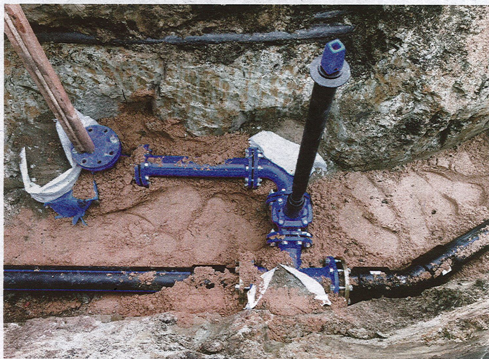
Budowa sieci wodociągowej.
