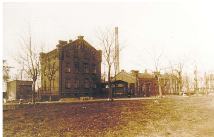
Tak wyglądała na początku XX w. zabudowa stacji uzdatniania wody Zaborowo (budynek palacza i maszynisty, budynek stacji pomp i kotłowni parowej, budynek odżelaziacza ze stacją filtrów).
