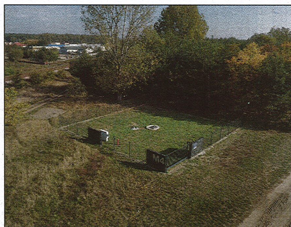
Studnia nr M4 zmodernizowana w 2017 roku
